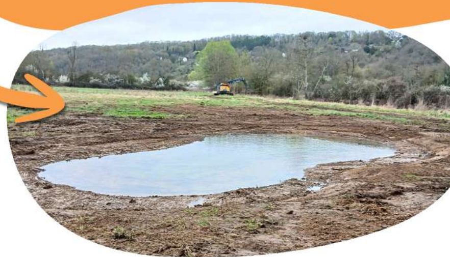
Mare créée sur une parcelle communale à Saint-Cyr-sur-Morin en janvier 2026
