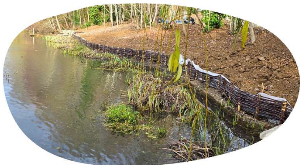
Restauration de berge par techniques végétales
